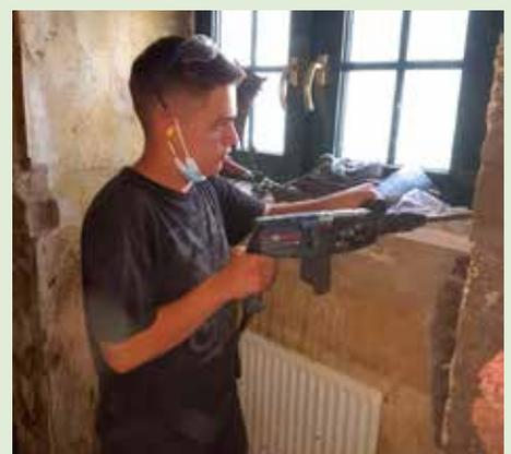
Der beschädigte Putz muss in der ganzen Etage vollständig von den Wänden runter - bis hoch zur Decke.
