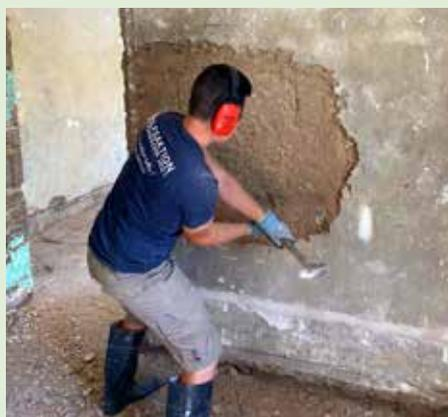
Der Putz wird entfernt, weil er später immer noch nach Fäkalien, Erdöl und Sonstigem stinken würde.
