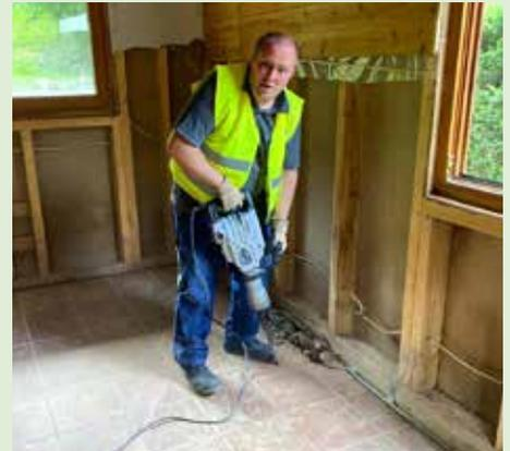
Hier hilft nur noch der Abbruchhammer! Für die Entkernung des Fußbodens kommt schweres Gerät zum Einsatz.
